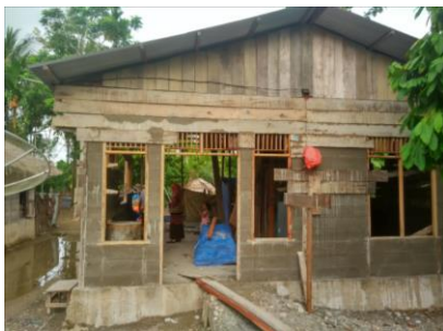
Gambar 5. Proses Pembangunan Rumah Non Panggung
